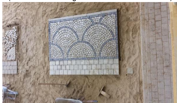
(Eine Pflasterübung am Lehrbauhof in Münster)
