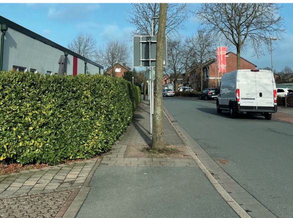
Abb. 27 | Behinderung des Gehweges durch Baumscheiben
