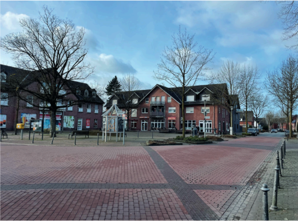
Abb. 37 | Pflasterung im Bereich Sporker Straße/Dorfplatz
