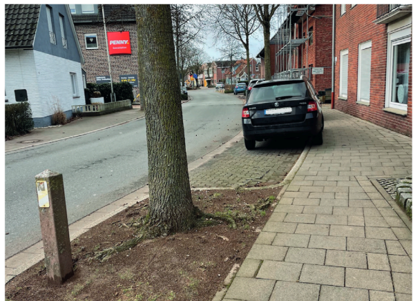
Abb. 28 | Verengter Fußweg entlang der Sporker Straße
