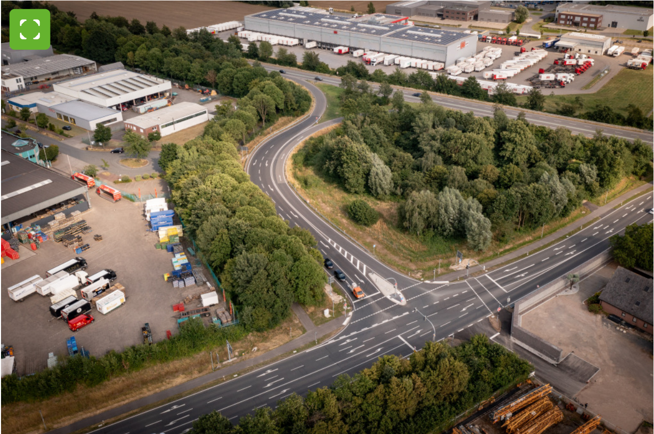
De verkeersroute in het gebied van het industriepark Bocholt is geoptimaliseerd. © Stadt Bocholt
