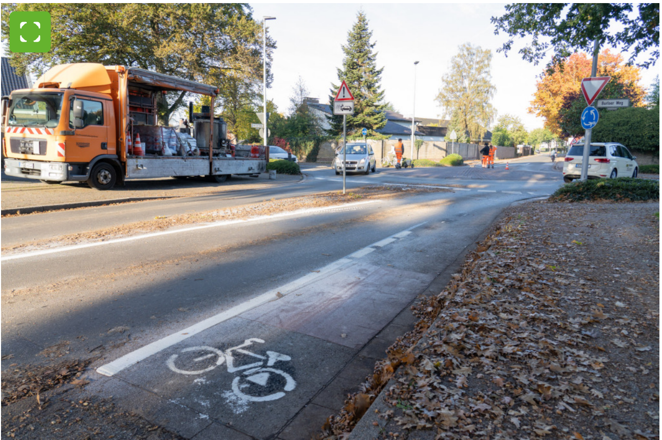
Aktuell werden die Fahrbahnmarkierungen am Kreisverkehr "Unter den Eichen" erneuert und die neuen Markierungen aufgebracht © Stadt Bocholt
