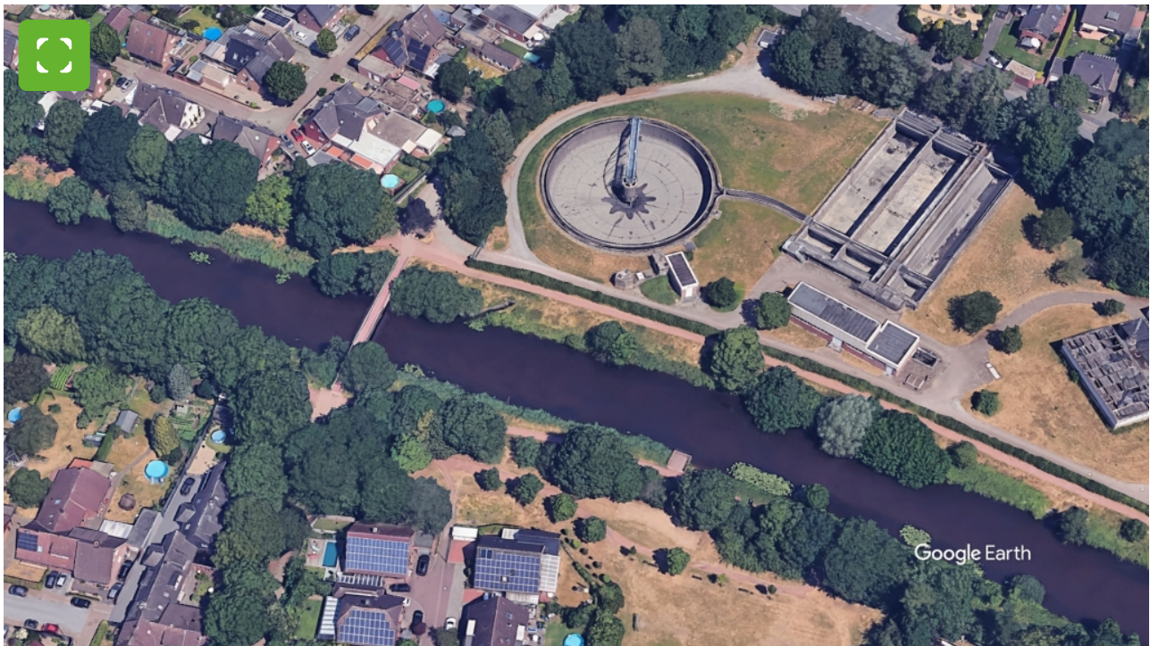
Aa-brug wordt gerenoveerd © Google Earth
