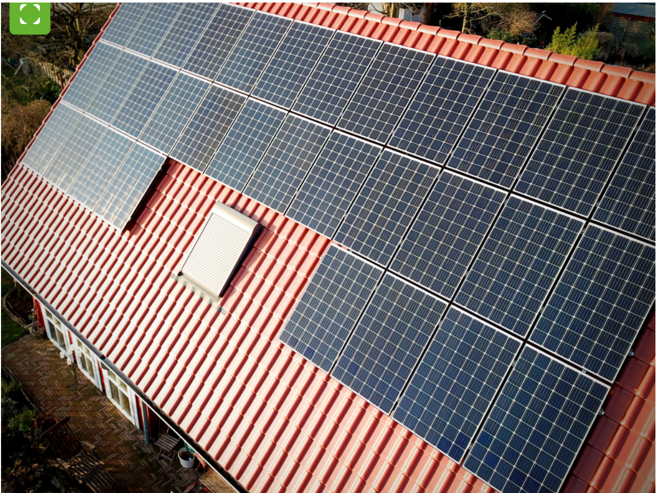
Photovoltaik oder Solarthermie liefern Strom oder Heizwärme aus Sonnenenergie © Stadt Bocholt
