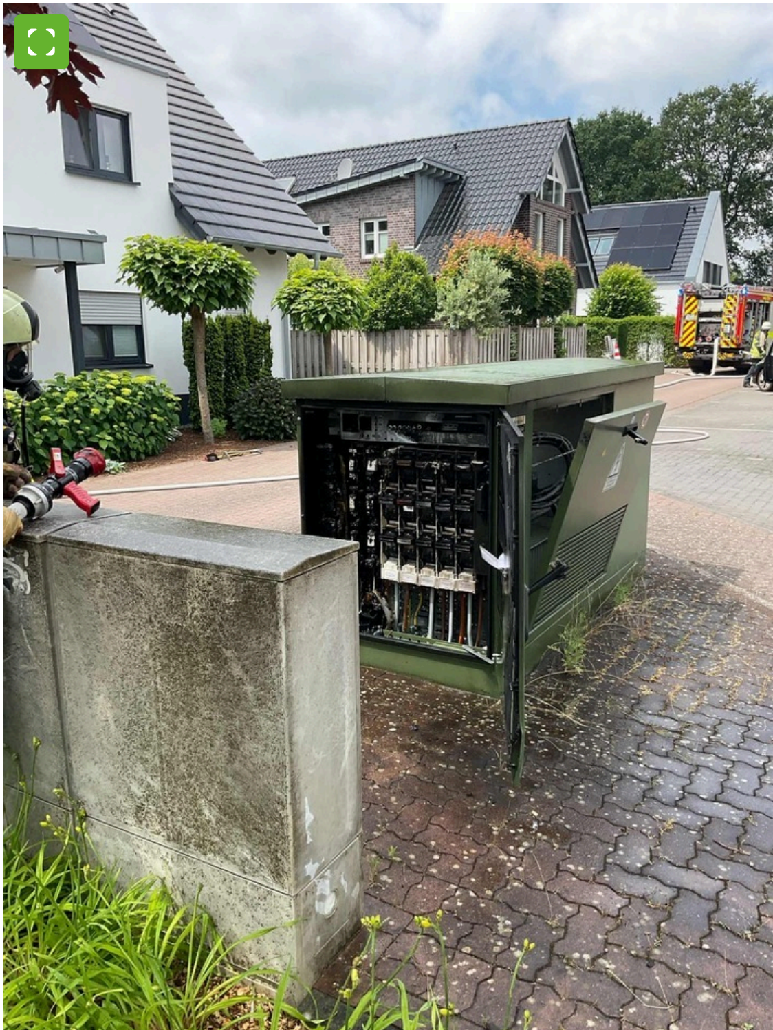
Foto na het verwijderen
