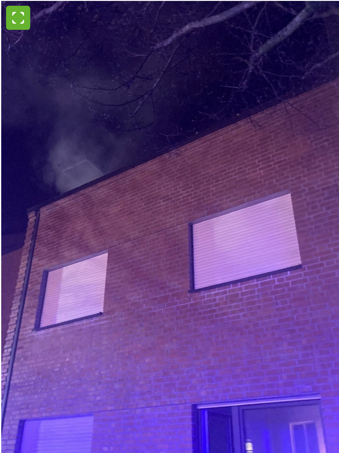
Foto tijdens het openen van het dakvenster
