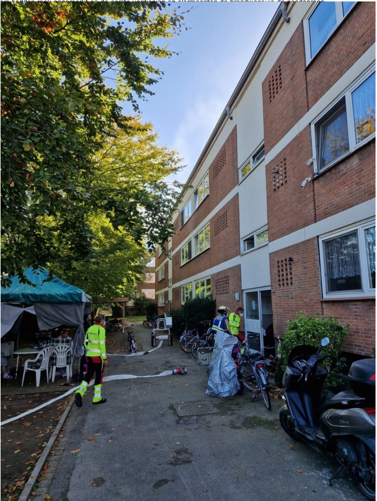
De brandweer kwam de flat binnen via het trappenhuis van het flatgebouw. © Feuerwehr
