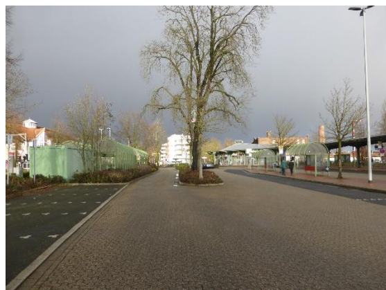
Der Bahnhofsvorplatz mit den Fahrradabstellanlagen, den Fahrgassen und der Bus-Mittelinsel
