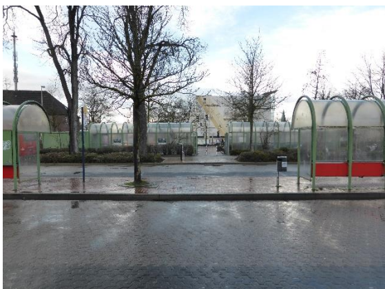
Blick auf die Bus-Mittelinsel und die Fahrradabstellanlagen
