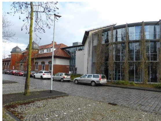
Das Medienzentrum mit anschließender Bibliothek in der Hindenburgstraße
