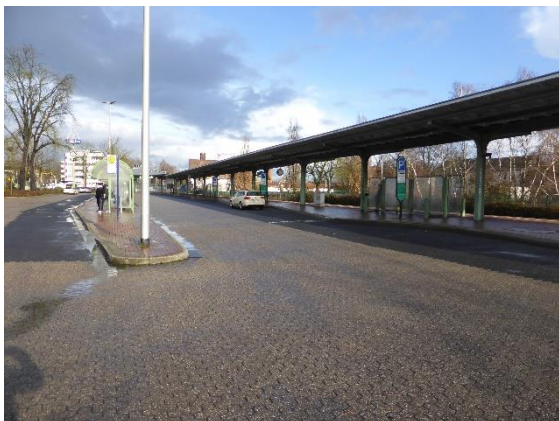
Der Bahnhofsvorplatz mit Bus-Mittelinsel und Kombibahnsteig
