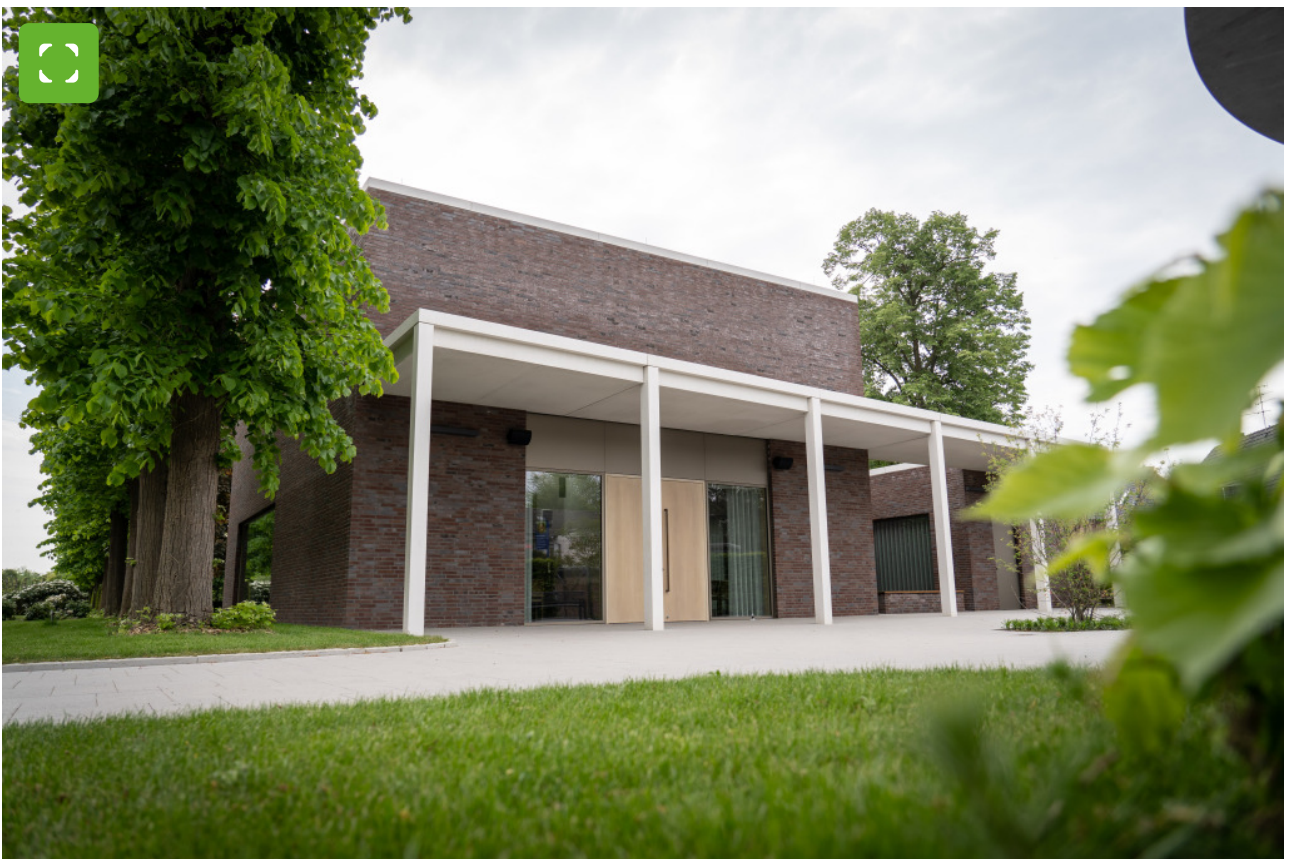
Eine Außenansicht der neuen Trauerhalle des Bocholter Friedhofs.
