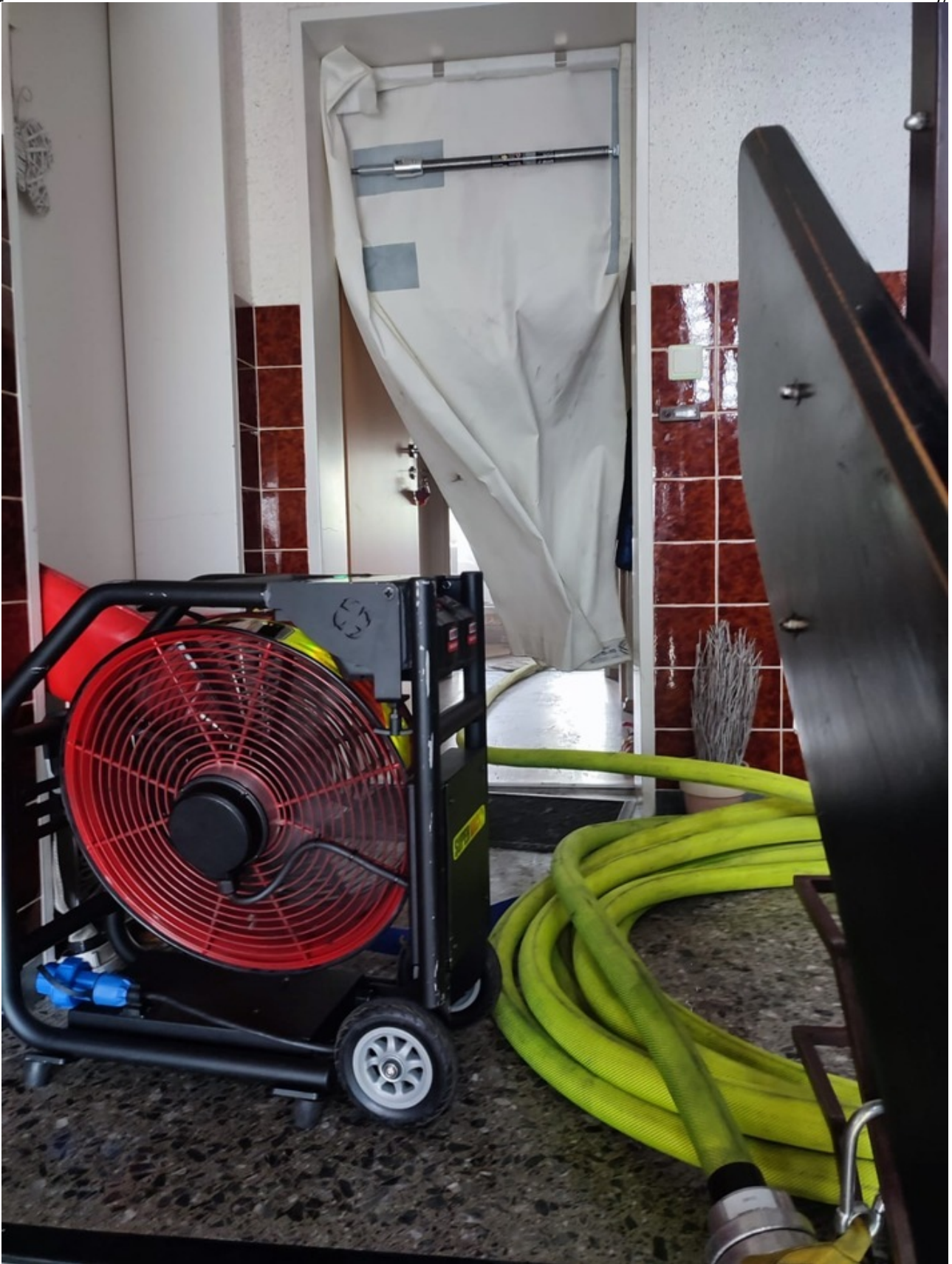
Rauchschürze im Eingangsbereich © Feuerwehr
