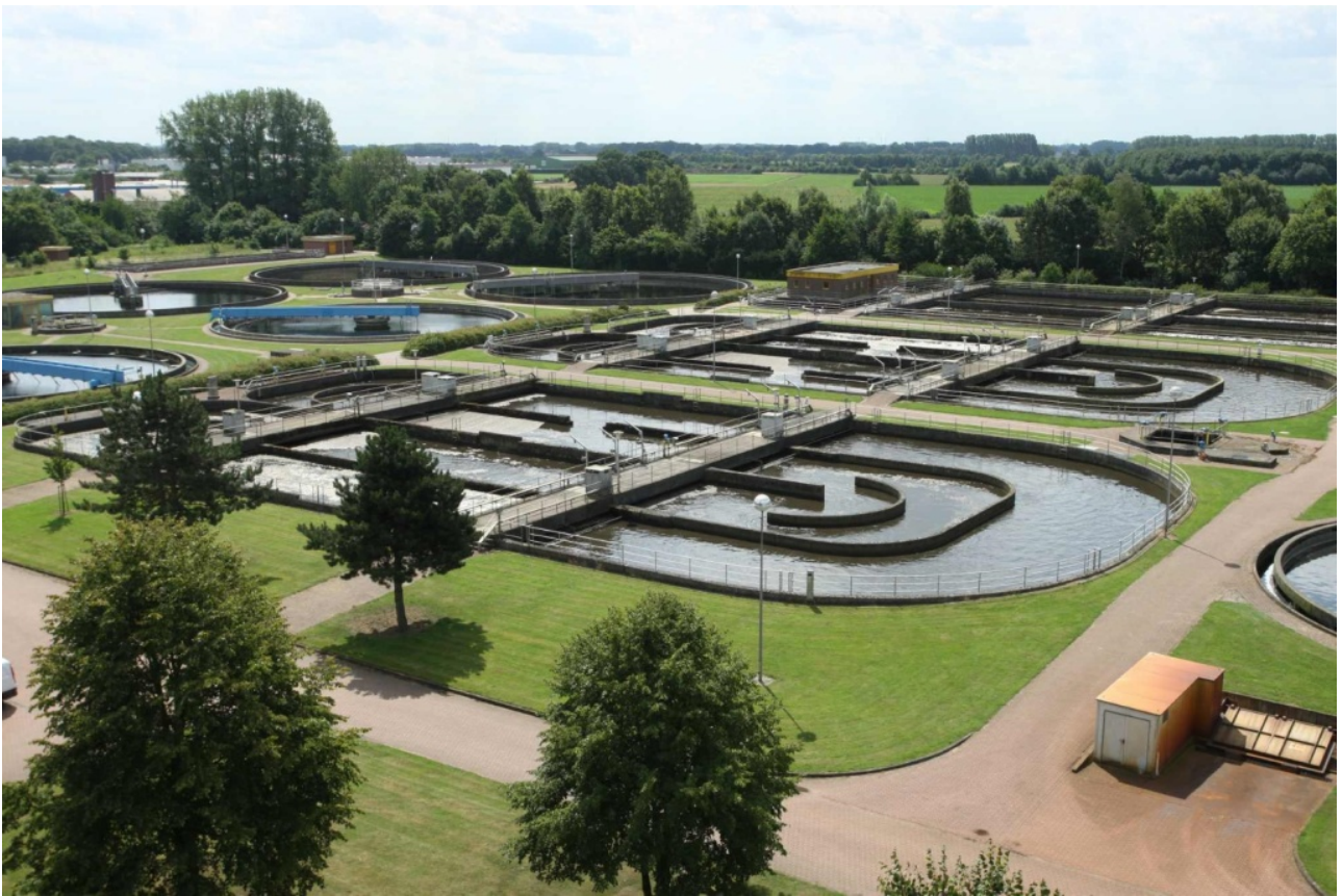
Kläranlage in Bocholt (Archivbild) © Stadt Bocholt
