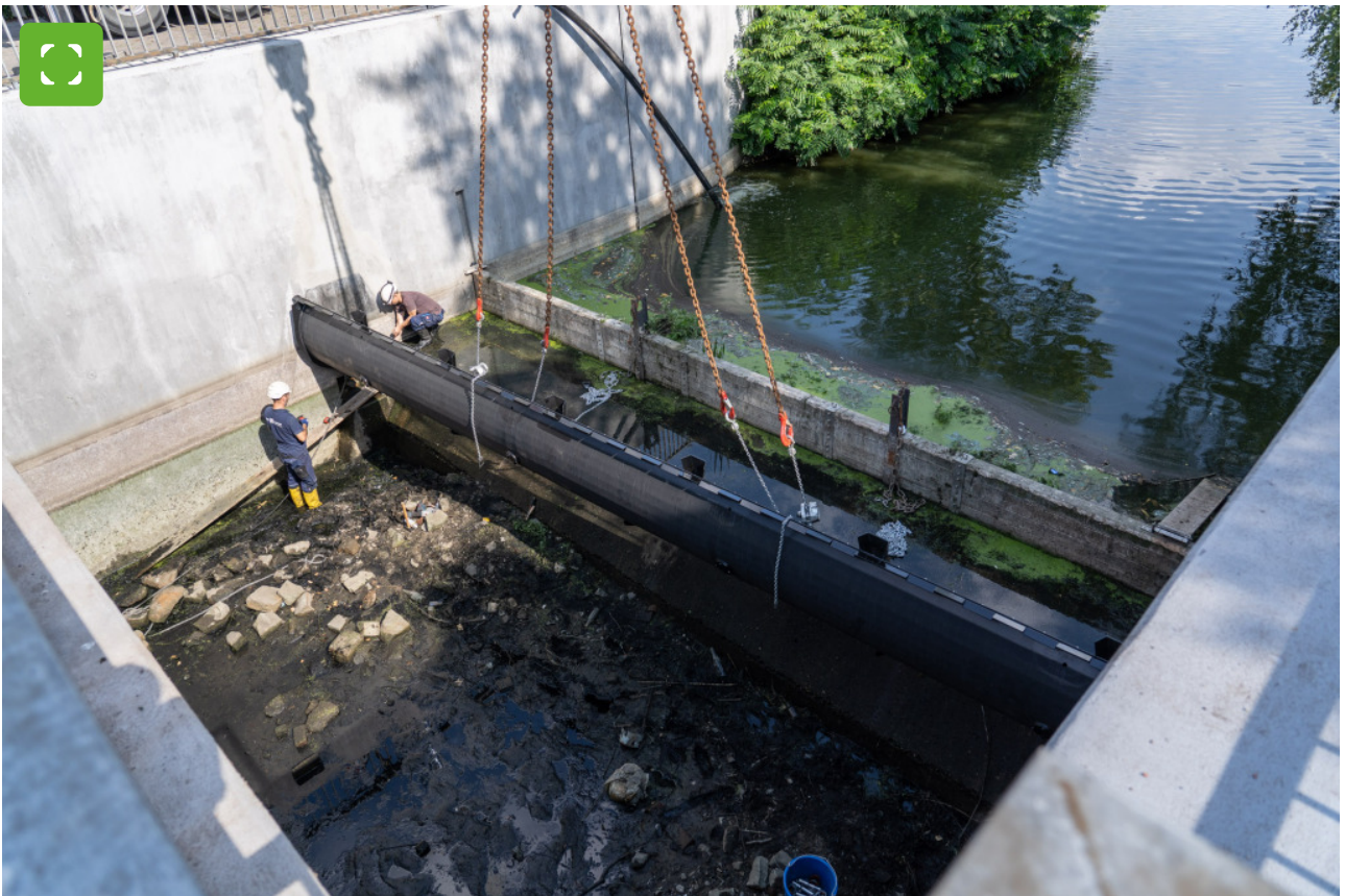
Das Stauwehr an der Königsmühle hat eine neue Klappe © Stadt Bocholt
