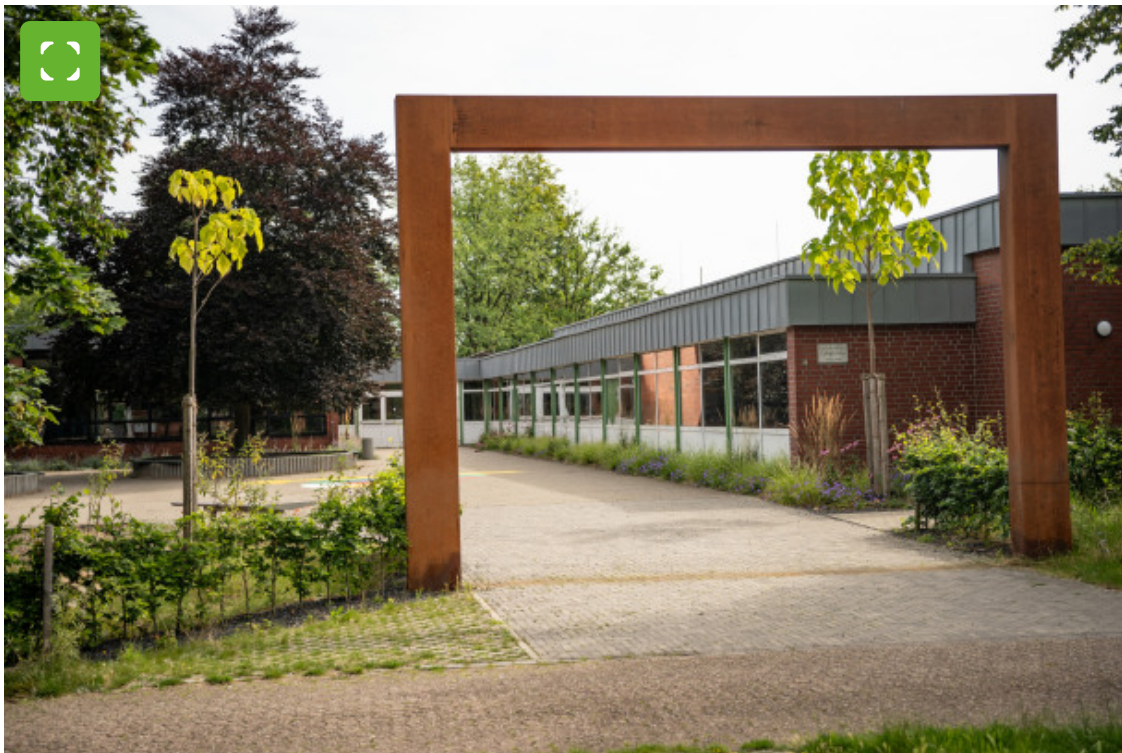
The Biemenhorst School on Weserstraße.
