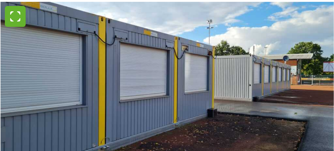
Neue Flüchtlingsunterkunft auf dem ehemaligen Gelände des SC 26 Bocholt: Neben mobilen Wohneinheiten stehen dort Aufenthaltsräume und Sanitäranlagen zur Verfügung. © Stadt Bocholt
