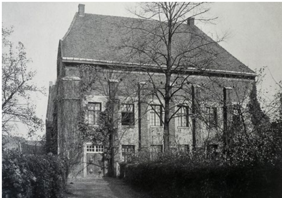
Die zu Dienstwohnungen umgebaute Kirche des Weißen Stifts, Ansicht von Süden
