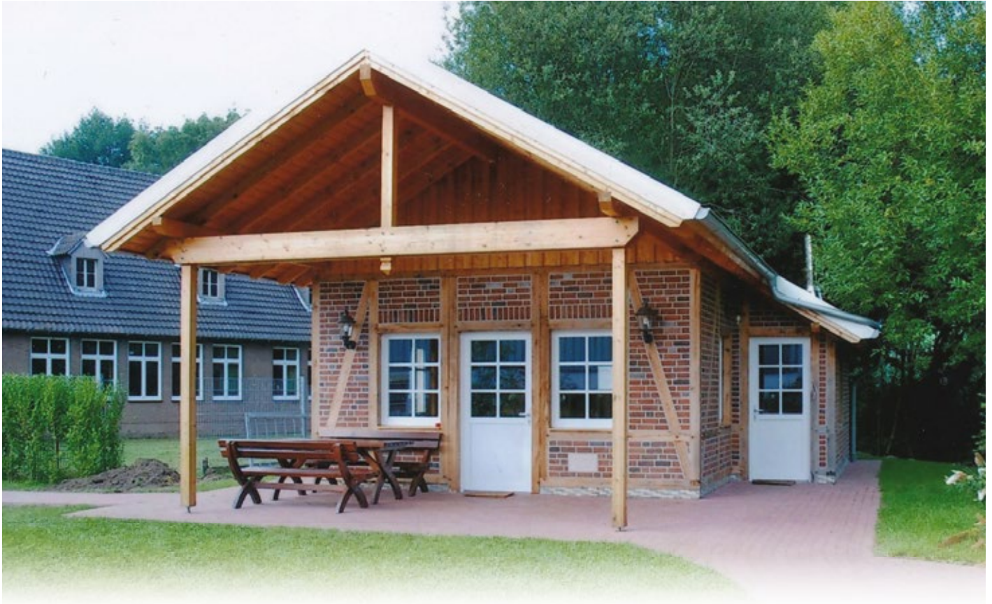
Das 2016 errichtete Backhaus an der Barloer Ringstraße
