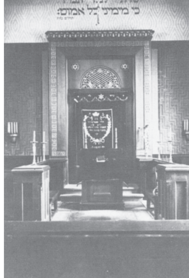
Innenansicht der Synagoge nach der Renovierung 1925 (StdA B, Bildersammlung, Jüdische Gemeinde, Foto: Kurt Herzfeld)
