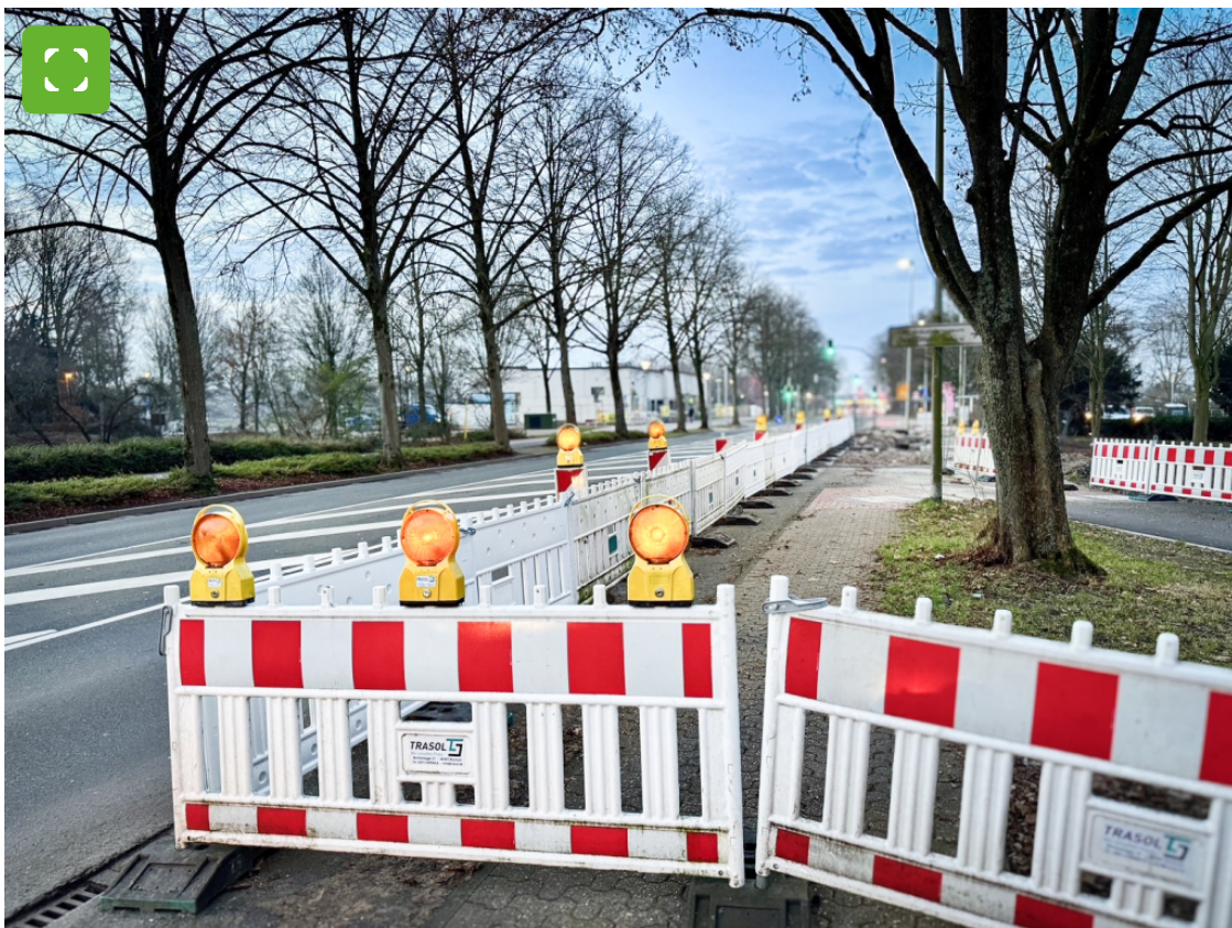
© Stadt Bocholt Verkehrseinschränkungen durch Leitungsarbeiten und Brückenbau an der Uhlandstraße.
